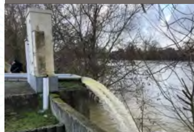
Mise en service des postes de crues (Compiègne)
