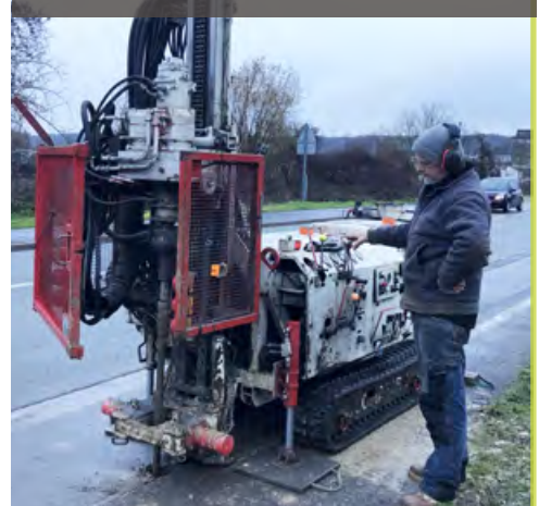
Sondage géotechnique (RD932 à Margny-lès-Compiègne)
