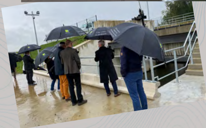
Observation de la vanne de régulation du barrage
