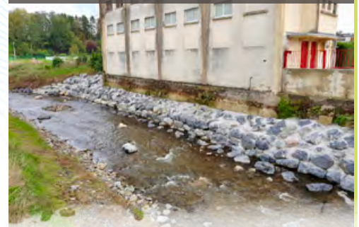
Création d'enrochements pour prévenir l'érosion (dojo)
