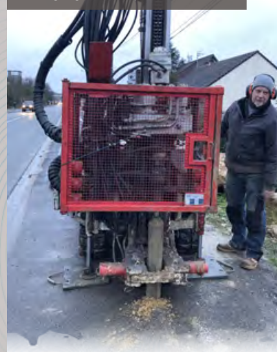
Sondages géotechniques sur la RD932
